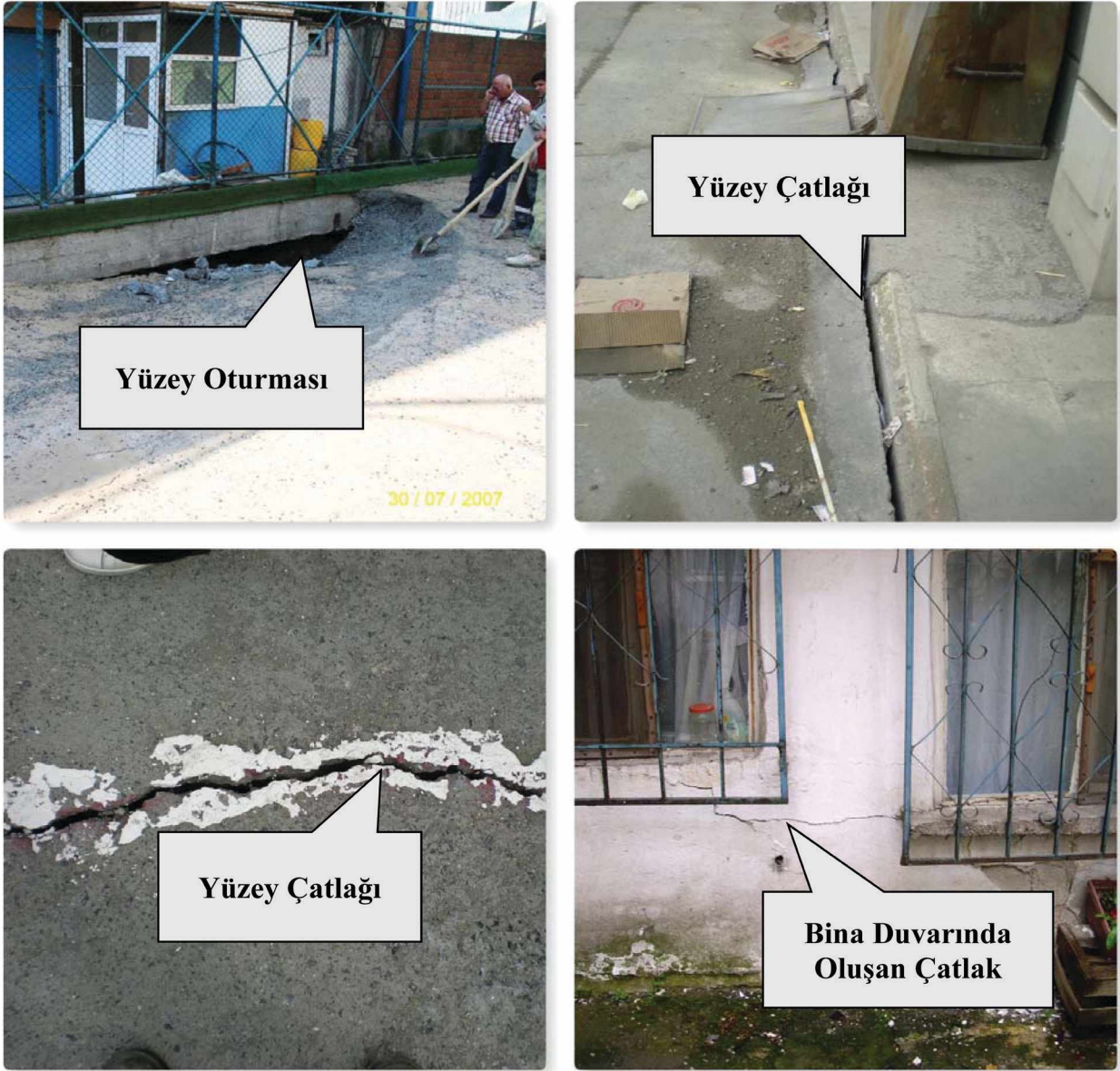
Şekil 3. Kirazlı-Olimpiyat-Başakşehir Metro hattındaki ikiz tünel kazılarının yüzeye ulaşan etkileri.
